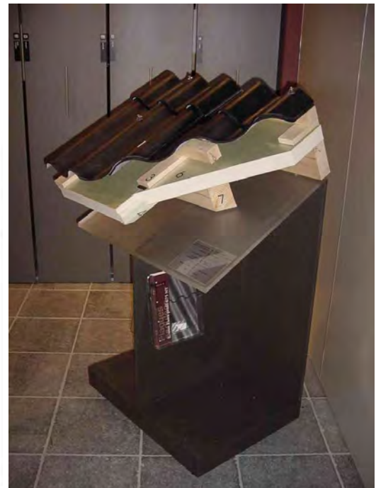
Foto 5: Golfplaat op onderstructuur bovenop isolatie
